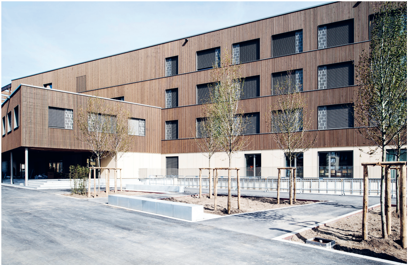
Le bâtiment présente un socle en béton et des façades en bois.
